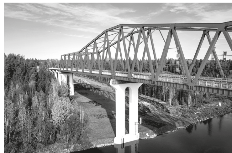
В Ленобласти продолжается строительство и ремонт мостов
