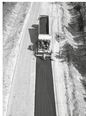
В планах на 2024 год — ремонт 200 км автодорог
